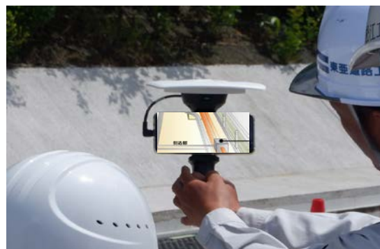
ARによる舗装下の埋設物の位置などを確認
