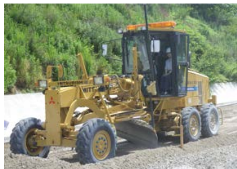
ICT機械（3DMCグレーダ）の施工体験（乗車）
