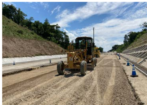
ICT機械（3DMCグレーダ）による路盤の敷き均し
