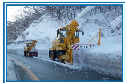
除雪（拡幅除雪）
