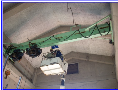
除雪基地設備点検
