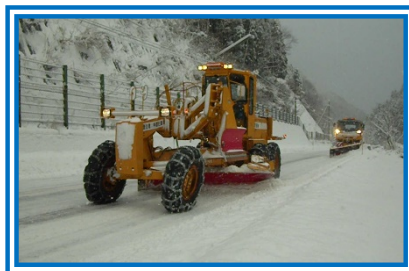
除雪（新設除雪）
