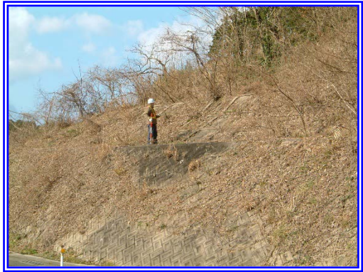
定期巡回（法面確認）
