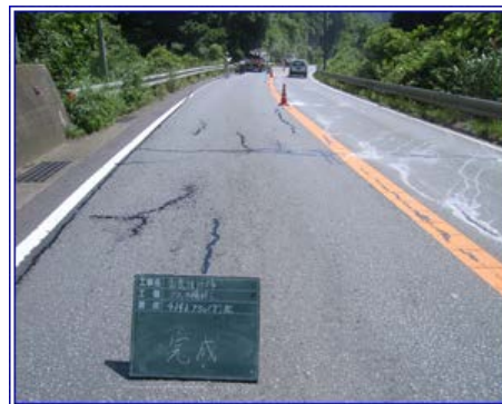
シール材の注入
