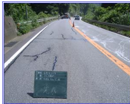
シール材の注入
