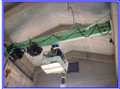
除雪基地設備点検
