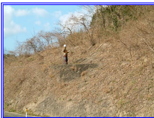
定期巡回（法面確認）
