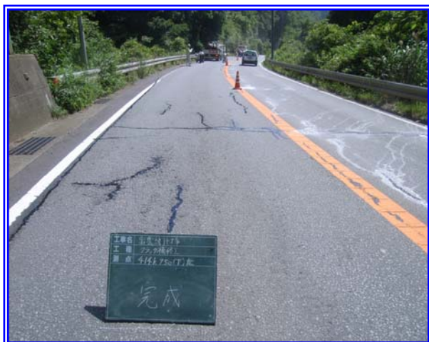
シール材の注入
