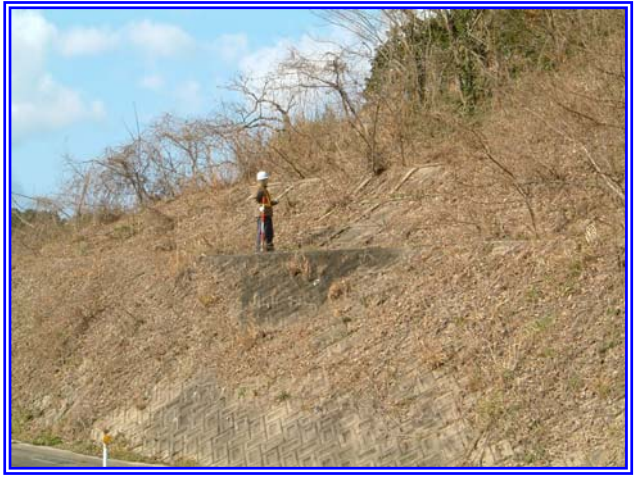
定期巡回（法面確認）
