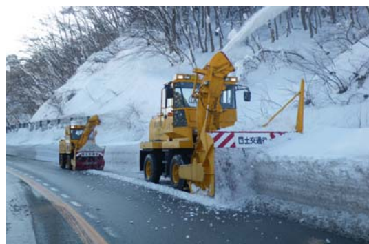
↑ 車道除雪（拡幅除雪）
