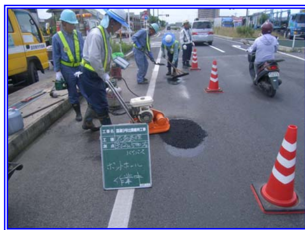
ポットホール処理
