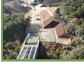
3. 湖陵多伎道路外法面工事 概要: 道路改良 受注者: まるなか建設(株)
