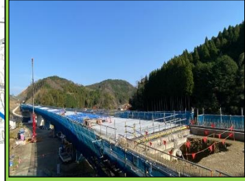
2. 東神西第2高架橋PC床版工事 概要: 橋梁上部 受注者: 川田建設(株)
