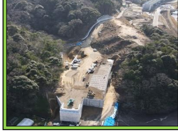
5. 常楽寺地区第2改良工事 概要: 道路改良 受注者: 今岡工業(株)
