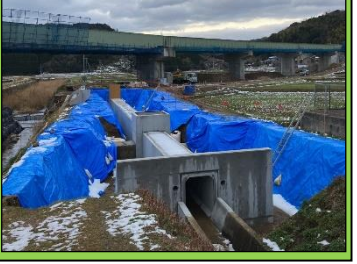
7. 湖陵IC改良第7工事 概要: 道路改良 受注者: 山陰建設工業(株)
