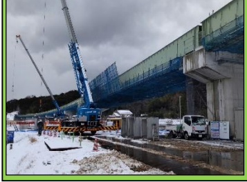
6. 常楽寺第2高架橋鋼筋上部第1工事 概要: 橋梁上部 受注者: 高田機工(株)
