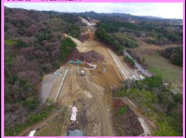
2. 二部地区改良第17工事 概要：道路改良 受注者：出雲土建株
