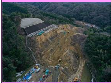
4. 二部地区改良第12工事 概要：道路改良 受注者：今岡工業株
