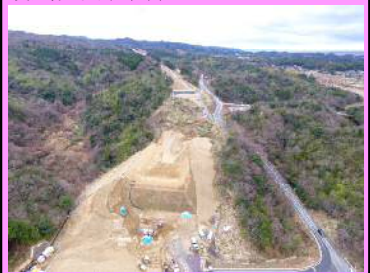
1. 二部地区改良第16工事 概要：道路改良 受注者：出雲土建株
