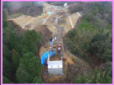
8. 久村地区改良第9工事 概要：道路改良 受注者：まるなか建設株
