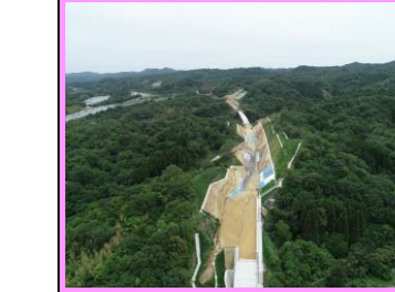
7. 湖陵多伎道路外法面工事 概要：道路改良 受注者：まるなか建設（株）
