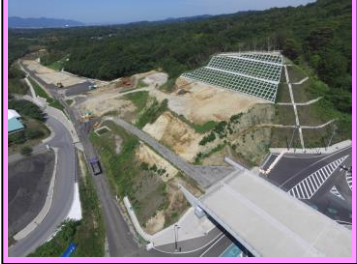
9. 多伎IC法面工事 概要：道路改良 受注者：榊中筋組
