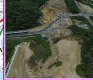
1. 三部地区改良第4工事 概要：道路改良 受注者：（株）フクダ
