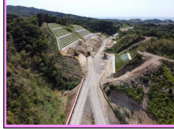
5. 久村地区外法面工事 概要：道路改良 受注者：カナツ技建工業㈱
