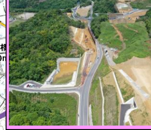
2. 二部地区改良第22工事 概要：道路改良 受注者：（株）都間土建
