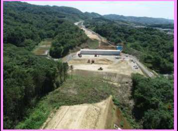
8. 久村地区改良工事 概要：道路改良 受注者：大福工業（株）
