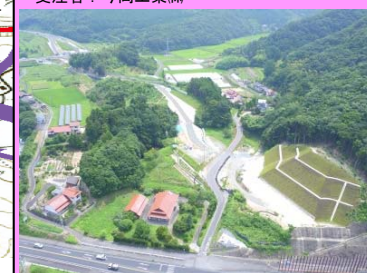
5. 久手地区改良第2工事 概要：道路改良 受注者：今岡工業㈱
