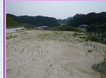
22. 久手高架橋下部工事 概要：橋梁下部 受注者：㈱フクダ
