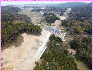
13. 鳥井地区改良第5工事 概要：道路改良 受注者：カナツ技建工業㈱
