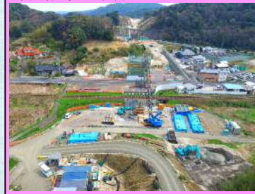
30. 久手跨線橋下部工事 概要：橋梁下部 受注者：松江土建㈱
