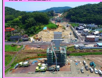
2. 久手地区改良第4工事
