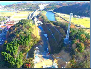
5. 静岡地区第1・2改良工事 概要：道路改良 受注者：大福工業㈱
