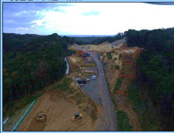
16. 長久地区第3改良工事 概要：道路改良 受注者：大福工業㈱
