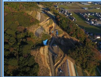
3. 長久地区改良工事 概要：道路改良 受注者：出雲土建㈱
