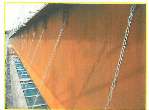
耐候性鋼材の橋桁 拡大写真
