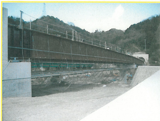
殿河内新橋鋼上部工事
