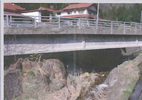
⑫橋台として使われた岩 かつてここに土橋があった。その橋の橋台として利用されていたという岩が、新しい橋の下に残されている。
