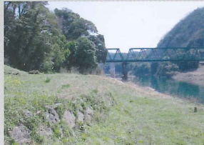
⑦川番所跡 江の川と尻無川の合流点付近には、銀山の抜け荷を監視する川番所があった。今は石垣の一部が残っている。
