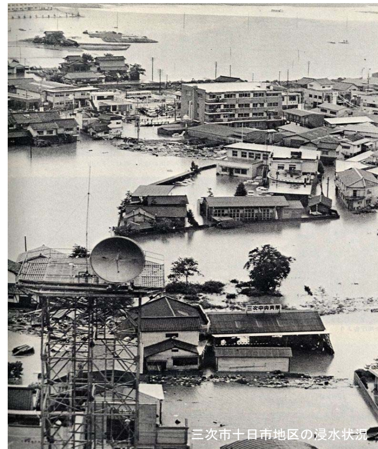
昭和47年7月豪雨の状況
