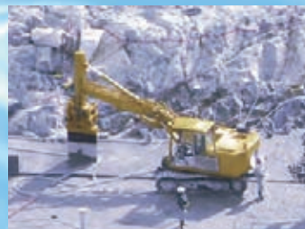
振動目地切機による目地切り
