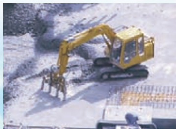
内部振動機による締固め
