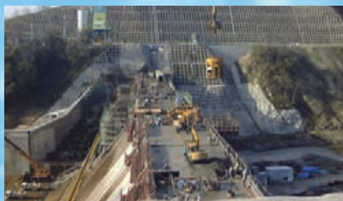
中位標高打設状況
