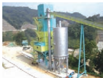
コンクリートプラント
