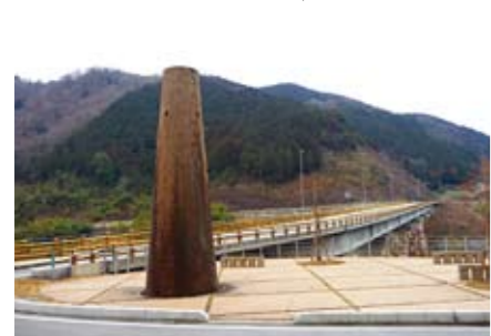
③羽地大橋
