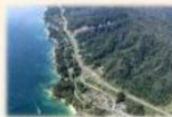
三陸沿岸道路（岩手県山田町）
