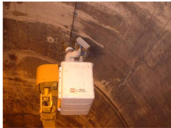
トンネル照明灯のランプ球替え
