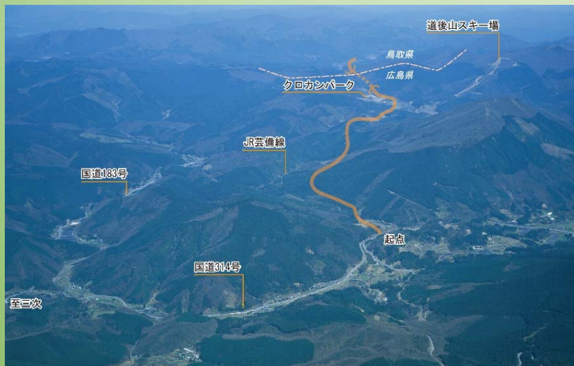
起点側(広島県)より
