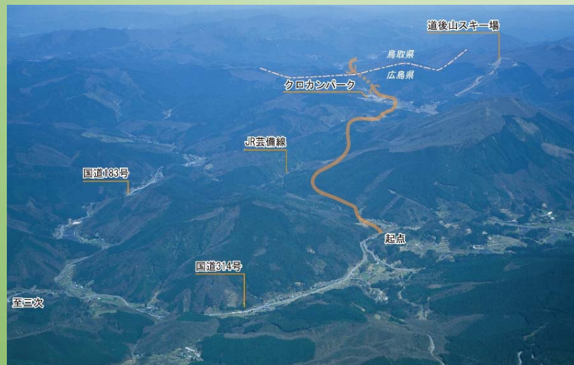
起点側(広島県)より
