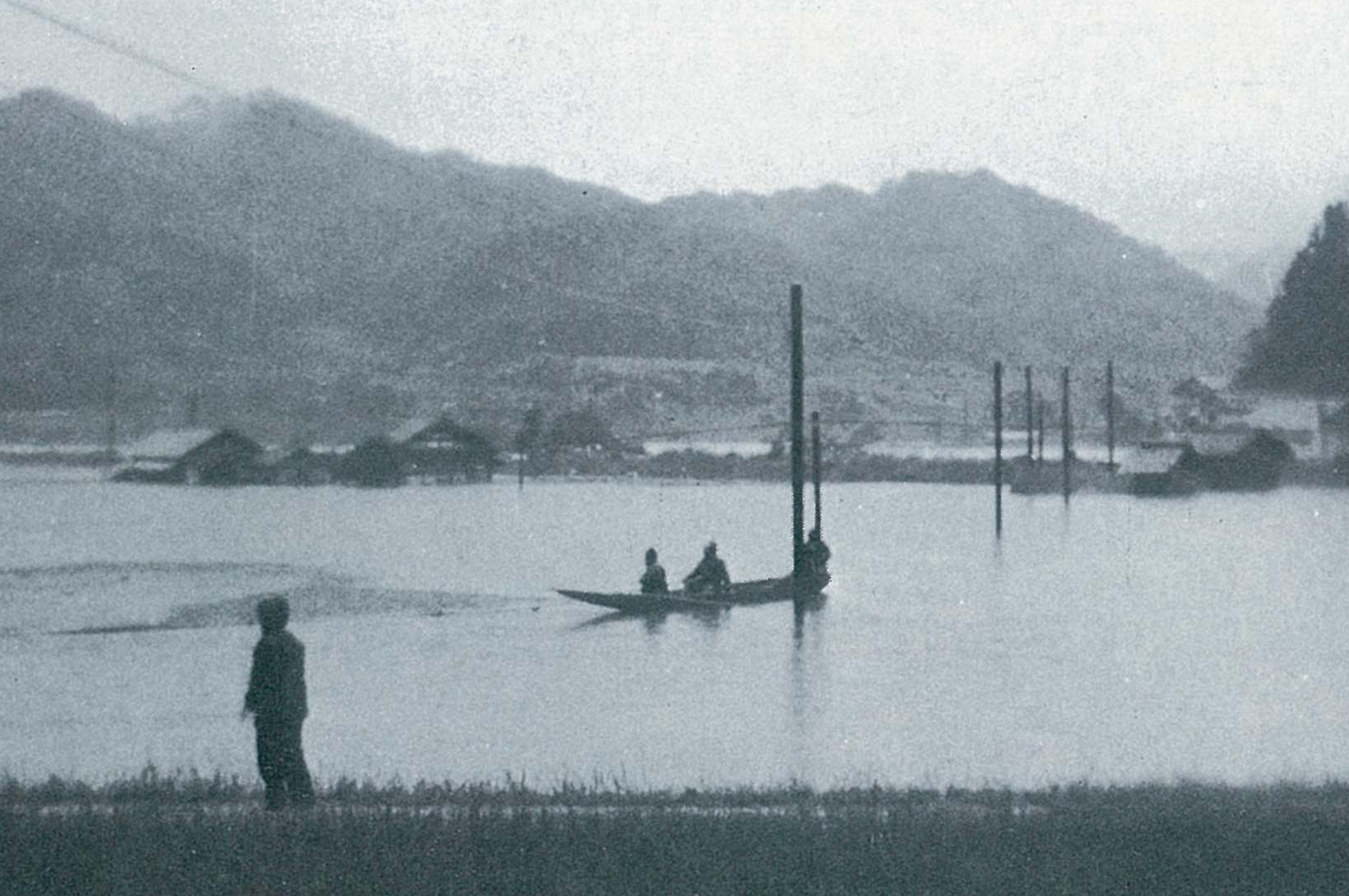
安芸高田市高宮町梶矢地区
