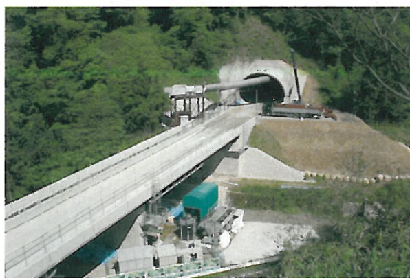
トンネル南側の坑口
