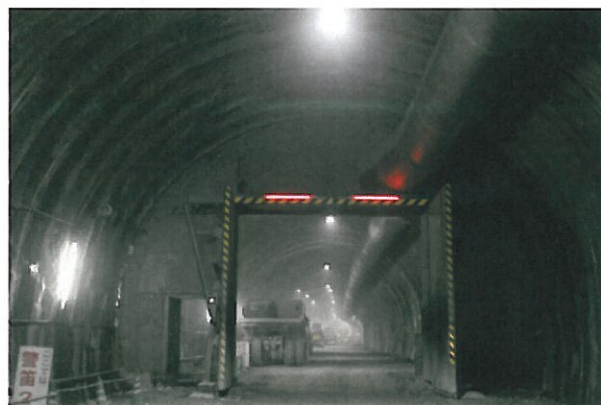
坑内にある防音扉
