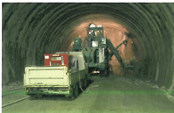
トンネルの掘削現場
