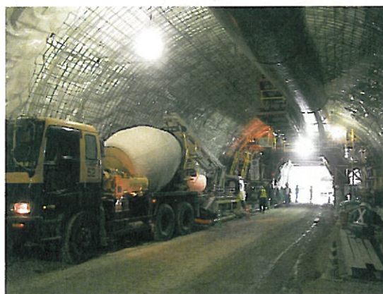
トンネルの覆工コンクリート打設
