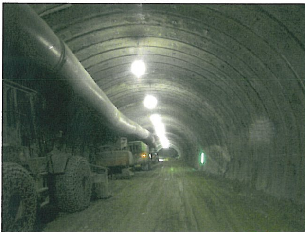
掘削中の先端部分
