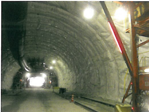
←トンネルに設置される防水シート
