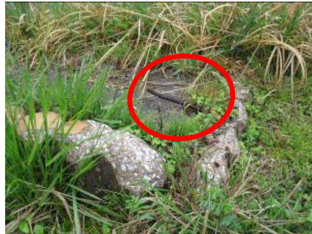
河川管理者において補修する。
