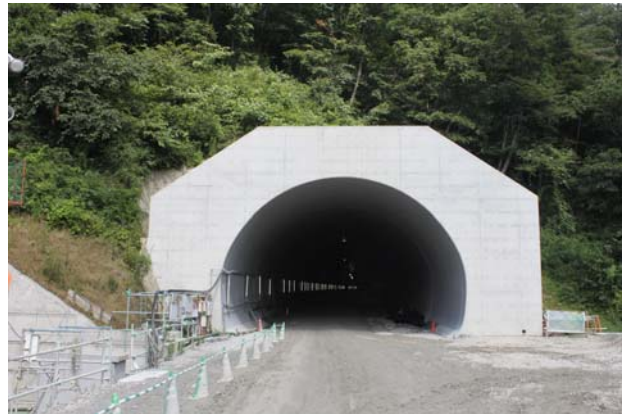
坑口の状況（現在）
