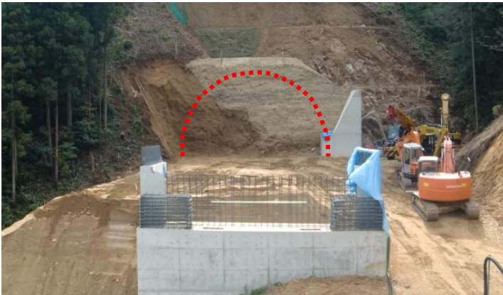
坑口の状況（着手前）
