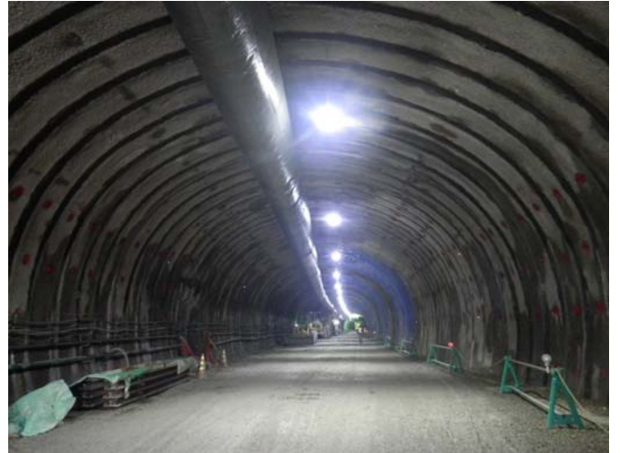
トンネル内の状況
