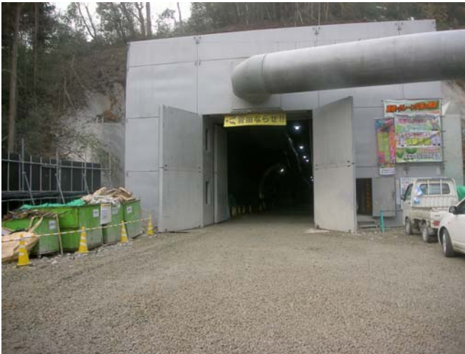
坑口の状況（現在）
