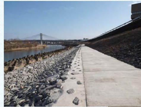
④ 【三次市福祉保健センター付近：河川管理用通路整備】 平成26年2月完成
