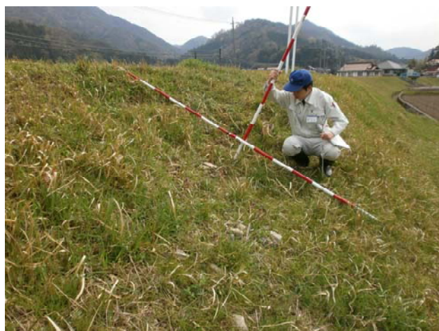
H24 堤防点検の様子
