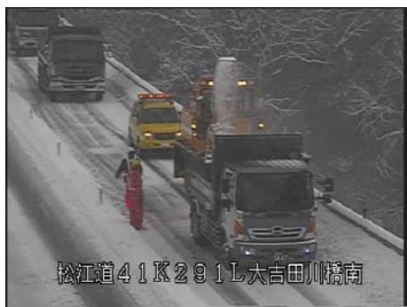
運搬除雪作業
