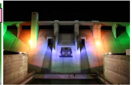
灰塚ダム堤体ライトアップ
