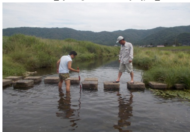
飛び石のぐらつきがないかを点検
