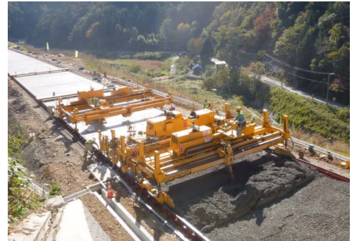
現場見学会での施工状況イメージ （コンクリート舗装）
