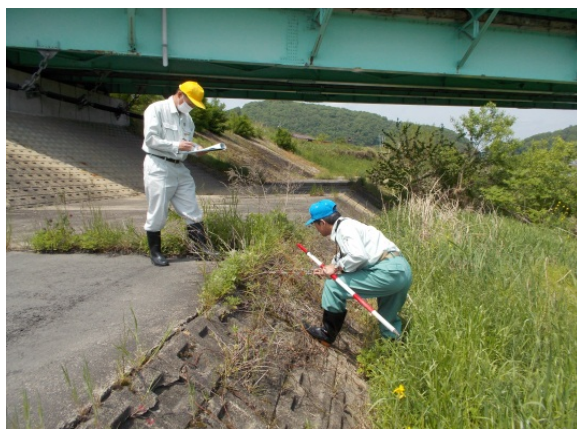
出水期前の堤防点検状況(昨年度)
