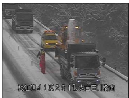
運搬除雪作業
