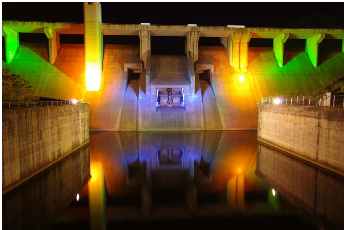
(ダム直下流の橋より)
