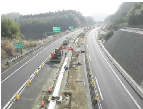
現在の工事状況（R3.1）
