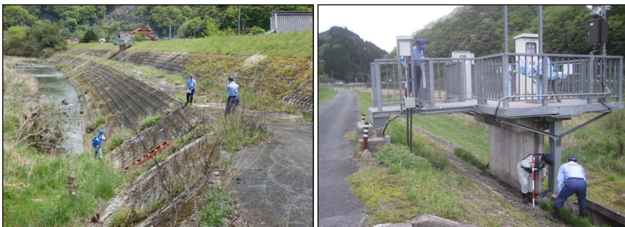
堤防点検状況
