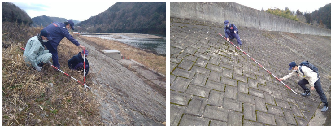
過去の堤防点検の様子
