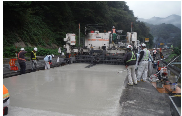
コンクリート舗装施工状況
