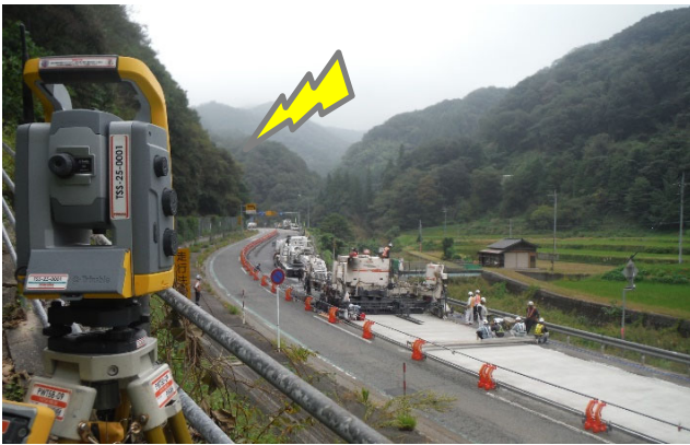
コンクリート舗装施工状況
