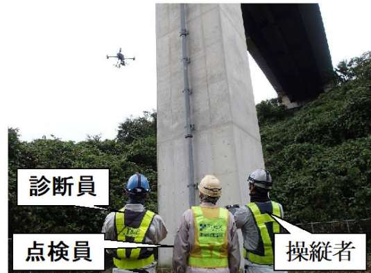
新技术による橋梁点検 (無人航空機(マルチコプター) による点検)
