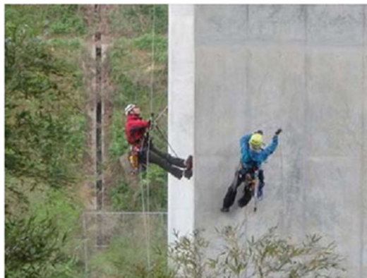
従前技術による橋梁点検 (ロープ高所作業による点検)
