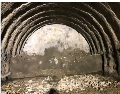
トンネル掘削先端（切羽）
