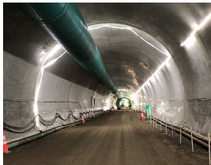
トンネル内（覆エコンクリート）
