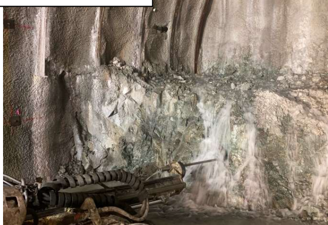
水抜きボーリング施工状況
