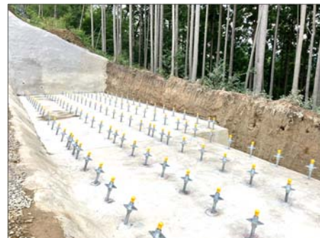
地山補強土工
