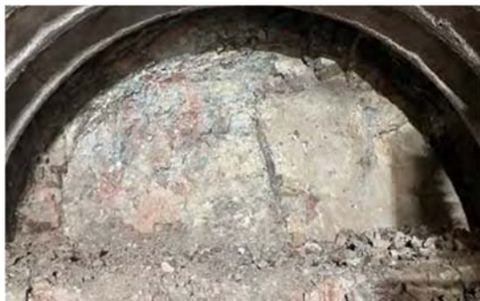
トンネル工事
