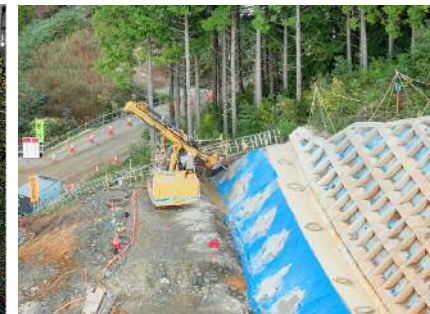
法面对策工の施工
