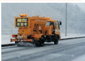
凍結防止剤の散布作業状況
